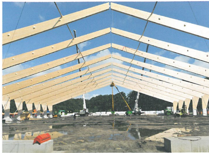
▲ Ein Blick entlang der Längsachse offenbart die Größe des Tragwerks
