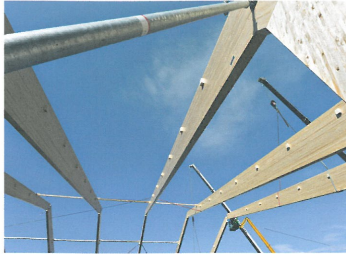
▲ Abgestrebte Verbandsdiagonalen über Montagestützen und Kettenzügen
