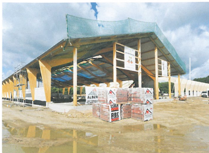
▲ Die enge Abstimmung zwischen Holzbauunternehmen und Planungsbüro sorgte für einen reibungslosen Bauverlauf
