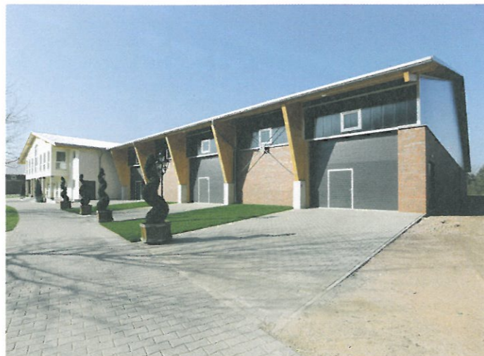
▲ Die Architektur betont die Holzkonstruktion, die trägt und zugleich stilvoll nach außen tritt
